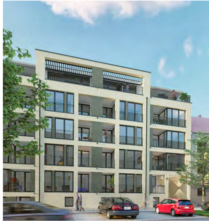
Straßenansicht des Mehrfamilienhaus von der Wiehbergstr.
